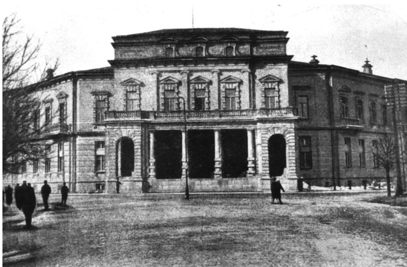
Fot. 1. Biblioteka im. Wróblewskich. Widok ogólny
